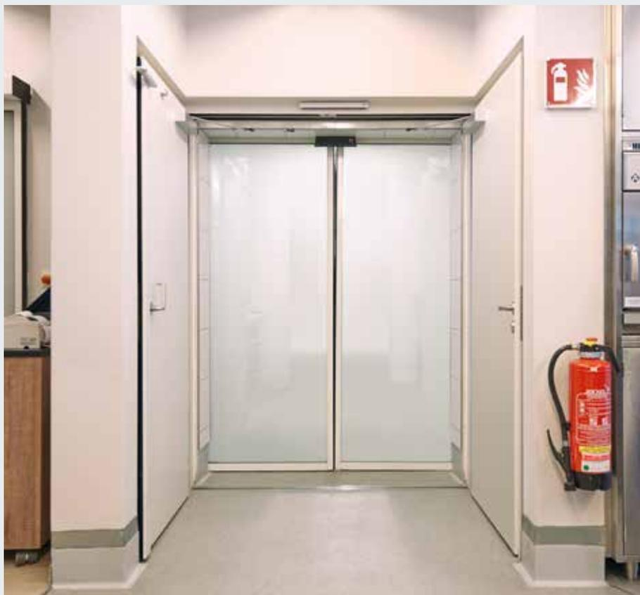
Внешний вид огнестойкой и дымопроницаемой двери (эксплуатация в дневное время)
